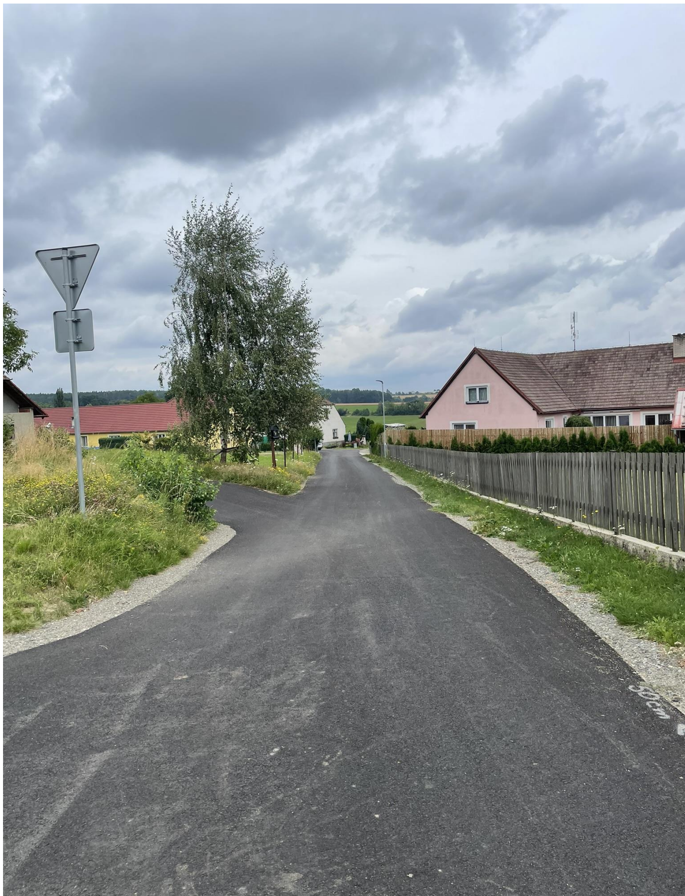
Foto 3: Stávající místní komunikace III. třídy
