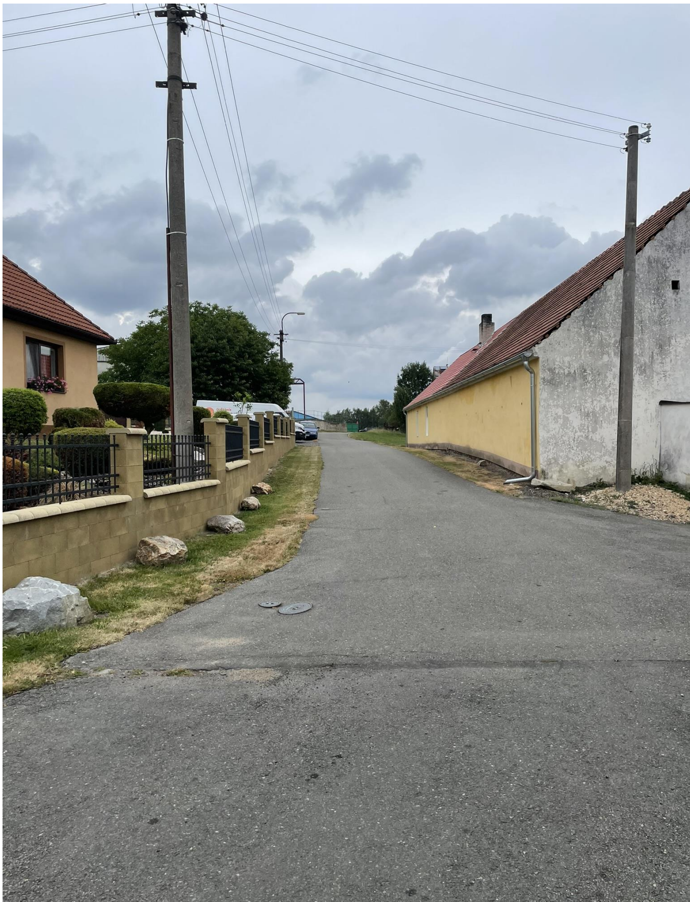
Foto 1: Stávající místní komunikace III. třídy
